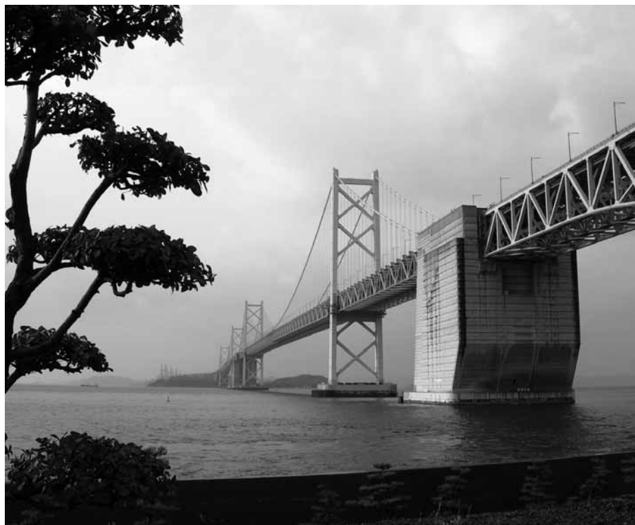
A Seto-Ohasi híd a főszigetet, Honsut köti össze a Sikoku szigettel
